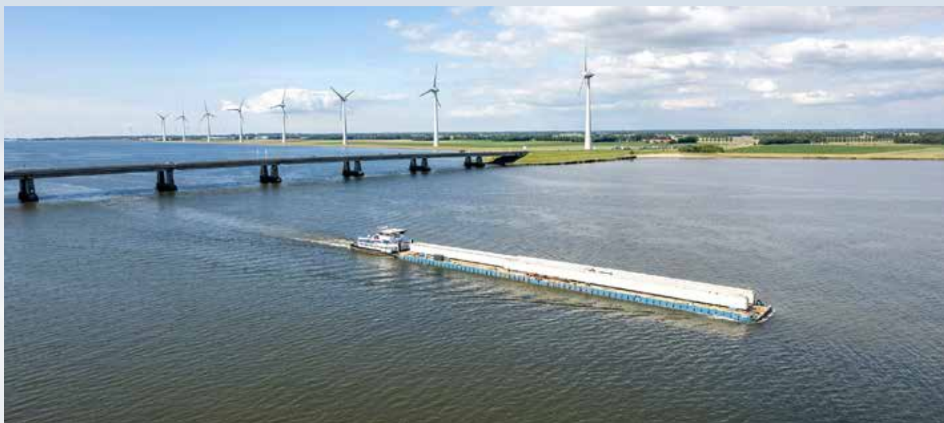
De 17 HIP-liggers van 87 ton en de 16 kokerliggers van 240 ton zijn via het water aangevoerd. (Beeld: Paul Poels video- en fotografie)
