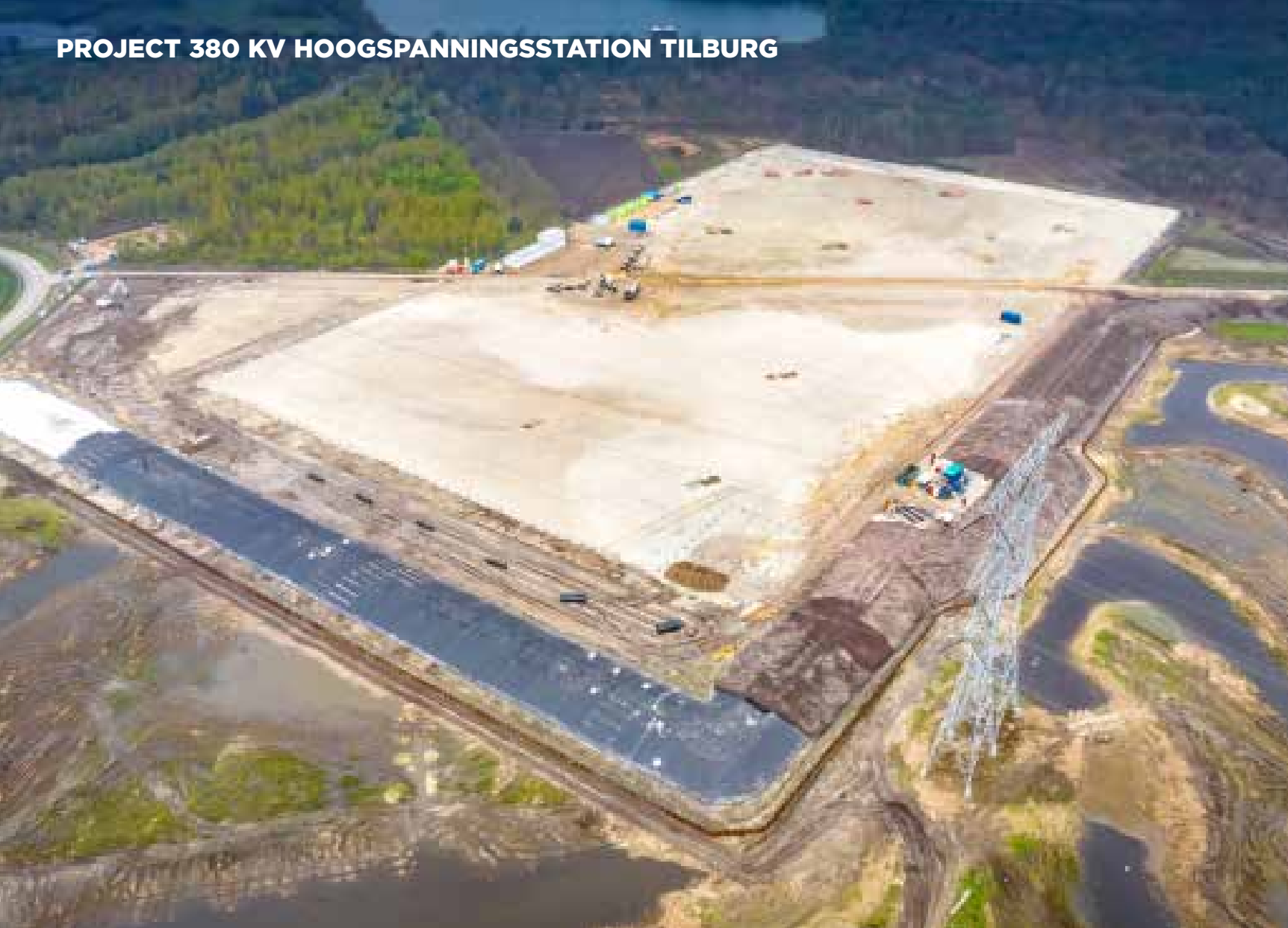
Antea Group ziet ook toe of de werkzaamheden volgens het opgestelde bodemsaneringsplan en bestek uitgevoerd worden.
