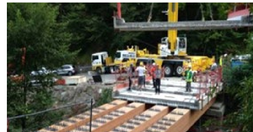
Project Pont de Riou, Alpes Maritimes, Frankrijk | Miebach
