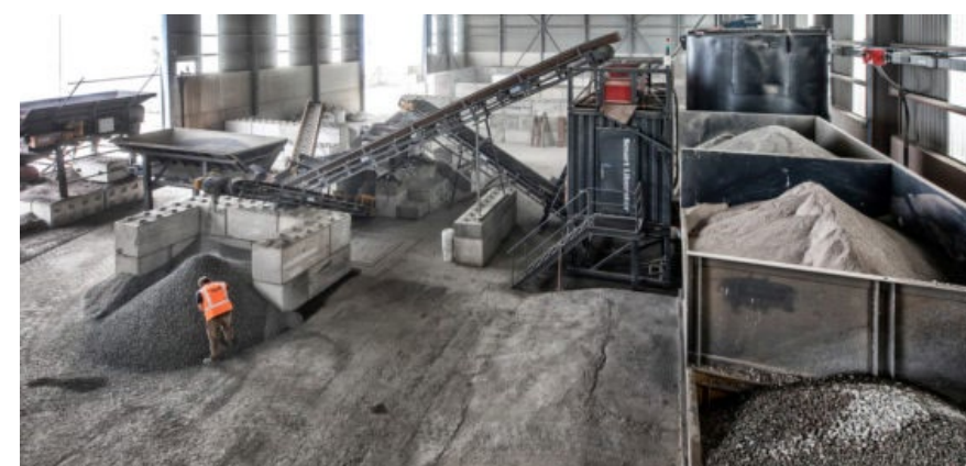
Liberator, recycling beton, Rutte groep
