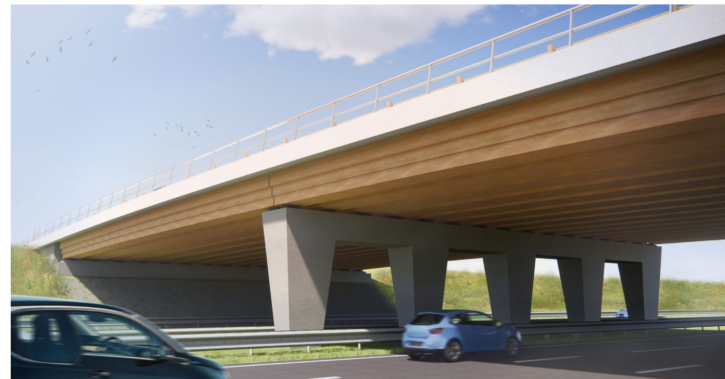
Architectonisch steunpunt > passend bij brugdekontwerp, modulaire opbouw nader uit te werken
