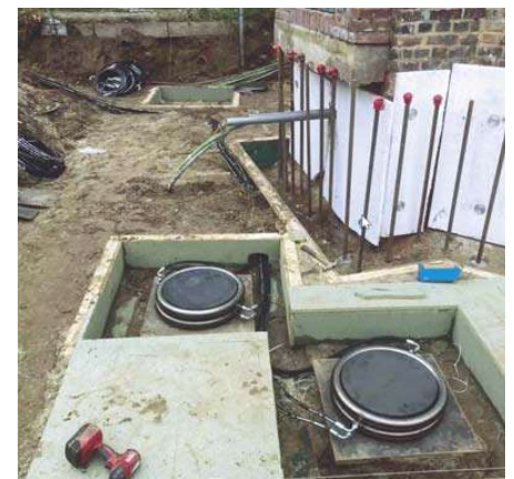
Figuur 12 – Opgenomen platte vijzels in de constructie direct bovenop de kopplaat op de palen.
