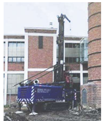
Figuur 7 – Aanbrengen van schroefinjectiepalen rond de schoorsteen.
