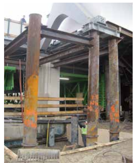
9. Tijdelijke hulptoren voor bouw spagaatkolom.
