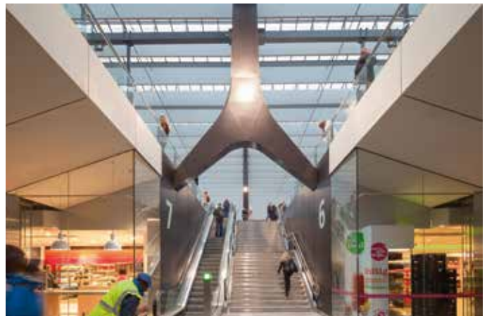
De oude passage is verbreed, met aan weerszijden retail. De invalidenlift staat aan de Provenierszijde.
