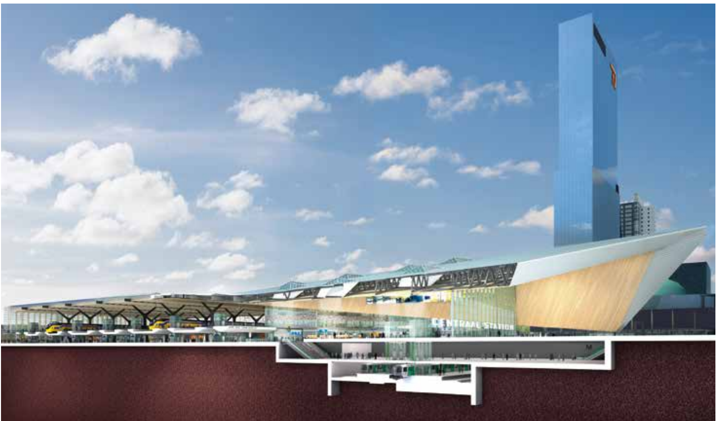
2. Het oude ondergrondse metrostation (1968) is uitgebreid van twee naar drie sporen voor aansluiting op de RandstadRail.
