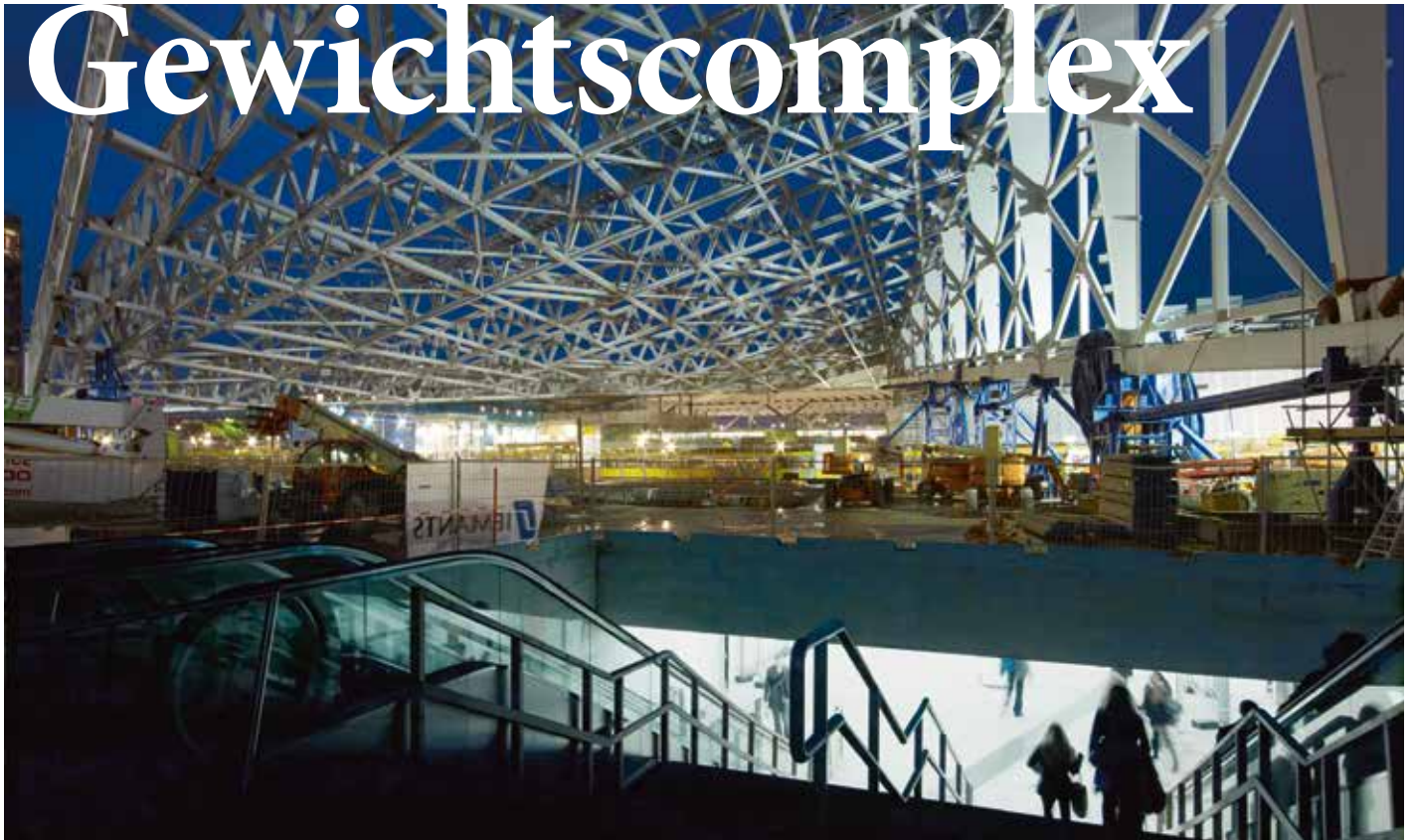
Stationshal in uitvoering, terwijl het metrostation (zuidelijke ingang) in bedrijf is.
