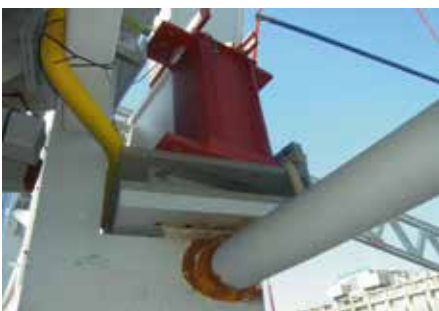
12a. Oplegging spant 1 op kolom 4.
