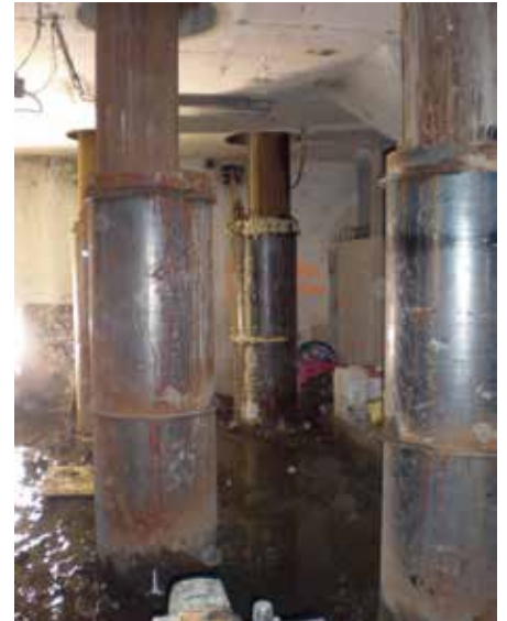
19. Palen onder de kernfundering, door de keldervloer.
