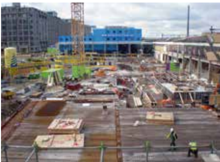
16. De fundering van de hal met rechts de kernfundering in aanbouw.
