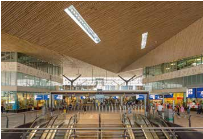
In totaal is 135.000 m 3 Western Red Cedar (brandklasse 1) verwerkt.
