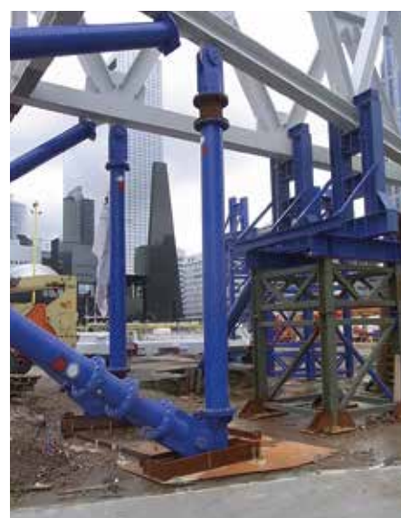
2. Hulpconstructie verankerd aan de dakplaat.
