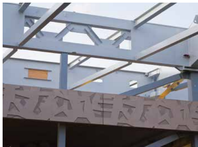
Foto 1. Links: met flankplaten 'verkoerde' doorsnede onderrand spant. Rechts: de capaciteitsvergroting is alleen gedaan in de zwaarst belaste zones.
