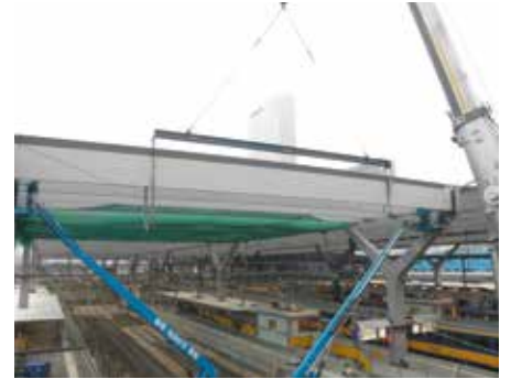
Montage van een houten ligger.
