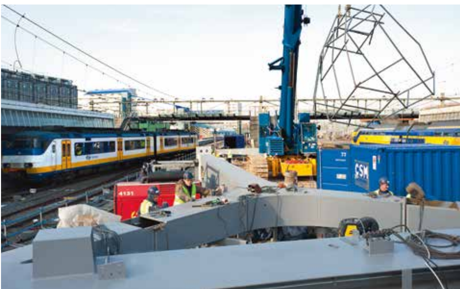
De kolomonderdelen worden horizontaal aangevoerd en vervolgens overeind geheesen.
