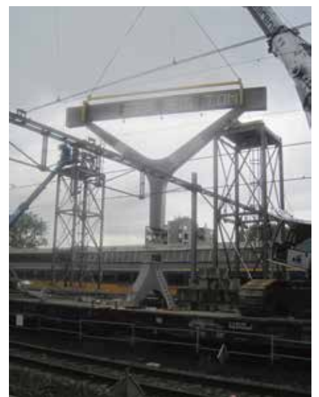
Plaatsing bovendee van een spagaatkolom.
