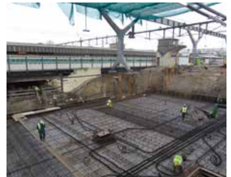
19. Palen onder de kernfundering, door de keldervloer.
