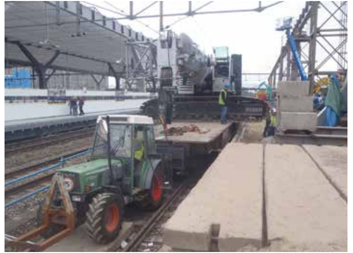
Verplaatsen kraan met ballast, september 2011.
