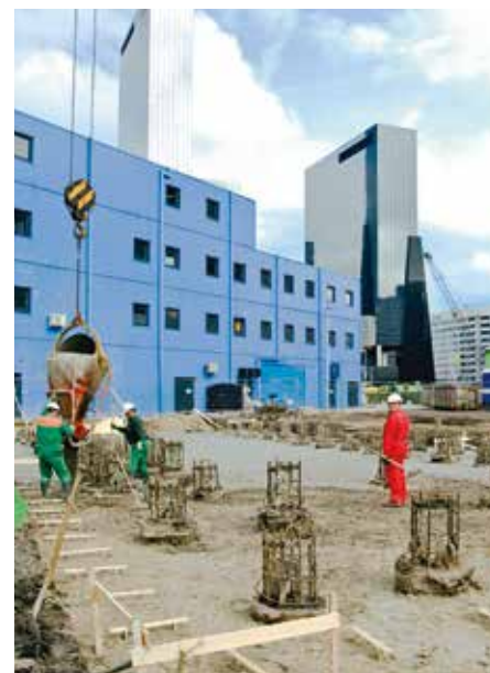
6. Funderingswerkzaamheden voor 'Vlek 1'.
