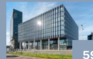
ASML De Run 1000: Innovatief kantoorcomplex in Veldhoven
