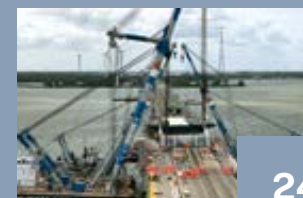
Haringvlietbrug: Gerenoveerd in recordtijd
